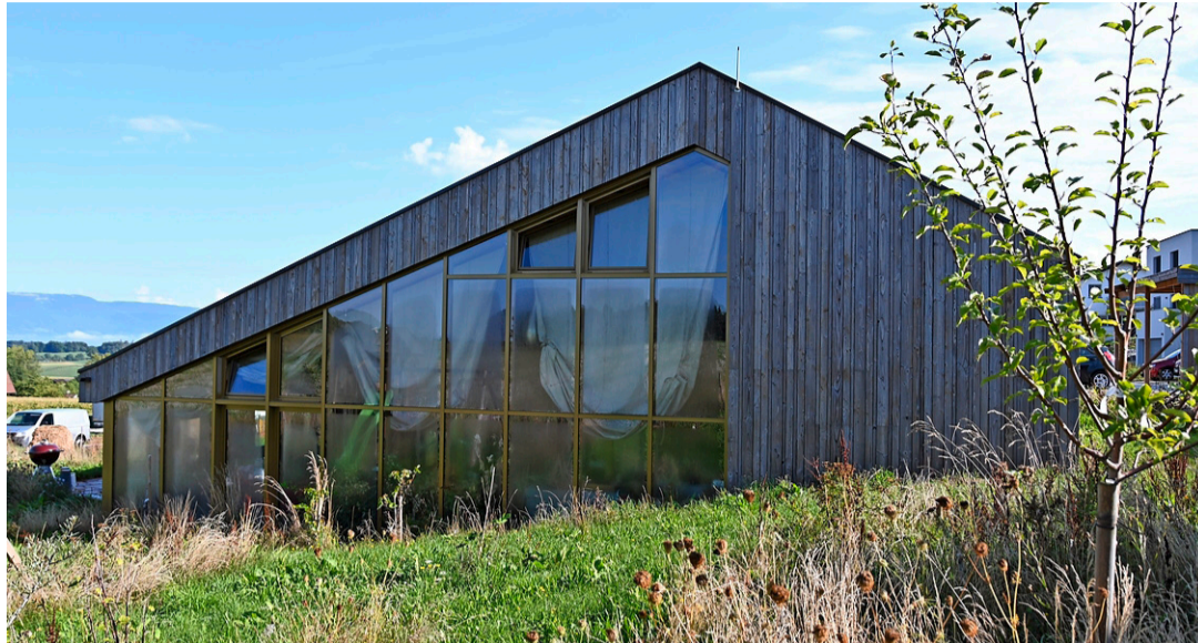
La façade sud de la maison est une serre qui fait office de chauffage central.
